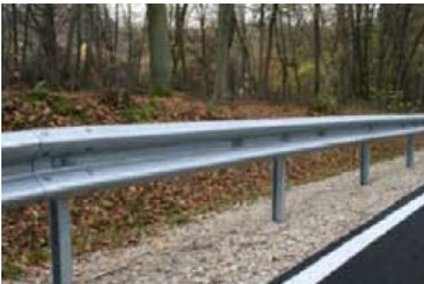
Obrázok 3: Pohľad na zvodidlo zvodidla ESP Plus PA 2,0 m
