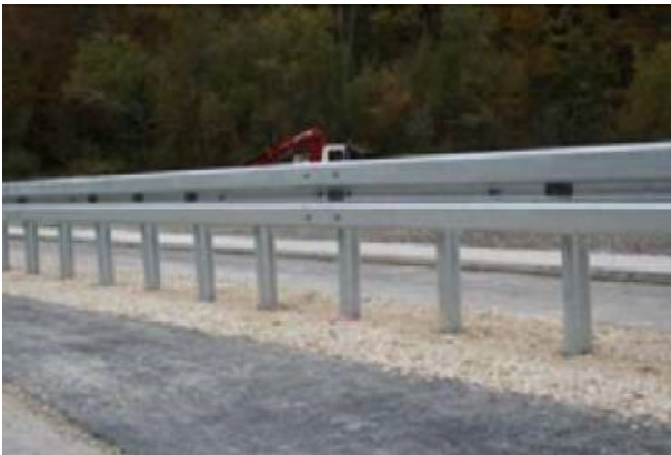
Obrázok 7: Pohľad na zvodidlo zvodidla ESP Plus W1
