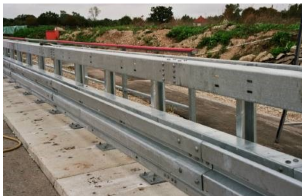
Obrázok 48: Pohľad na zábradľové zvodidlo Super-Rail Plus BW
