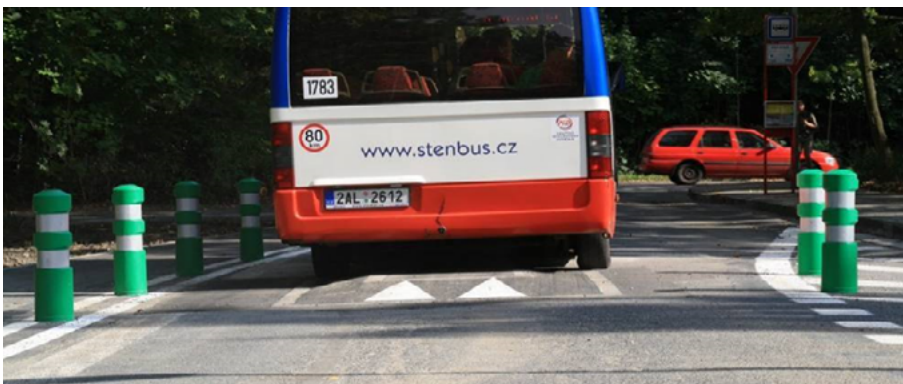
Obr. 53. Dopravný vankúš a plastové stĺpiky na upokojenie dopravy pred ZŠ Polesná, Újezd nad Lesy, ČR.
