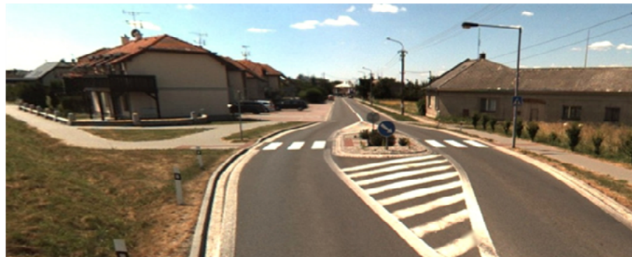
Obr. 33. Obojsranné vybočenie jazdných pruhov prostredníctvom deliaceho ostrovčka s priechodom pre chodcov pred vstupom do obce Továr, ČR.
