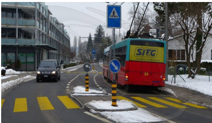
Obr. 11. Autobusová zastávka zriadená priamo v jazdnom pruhu vozovky oddeleného od protismerného pruhu stredovým ostrovčekom umožňujúcim bezpečné prechádzanie chodcov cez cestu
