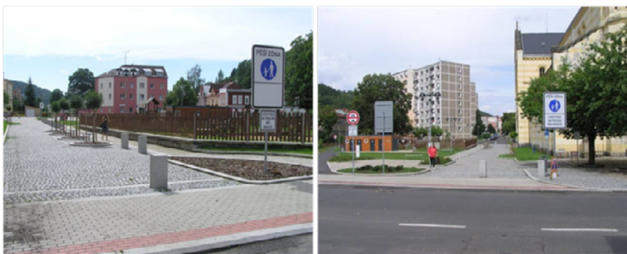
Obr. 58. Pešia zóna vybudovaná upravením pôvodne prejazdnej miestnej komunikácie a zanedbanej zelene v okolí kostola v meste Kraslice, ČR
