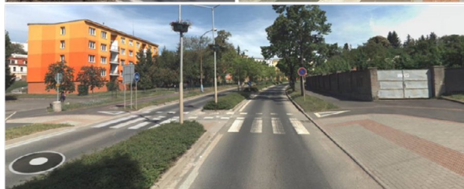
Obr. 45. Dopravné upokojenie prieťahu cesty II. triedy v meste Kadaň, ČR, formou viacúčelového stredného deliaceho pásu
