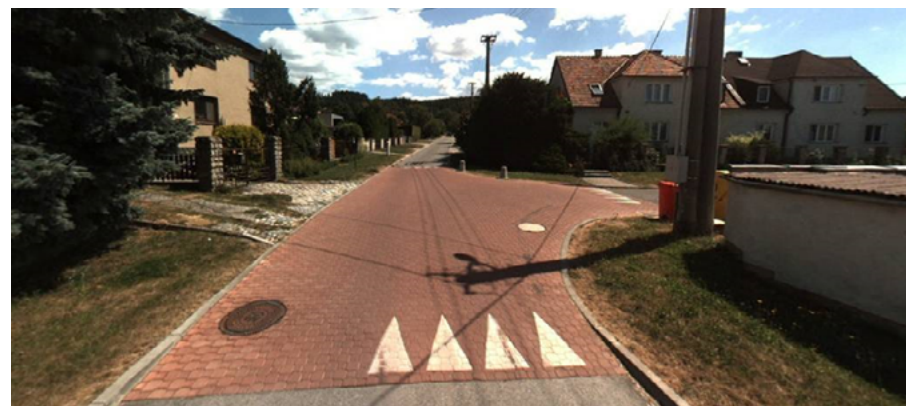
Obr. 56. Vyvýšená plocha križovatky bez vyznačenia prednosti jazdy v Zóne 30 v obci Tovéř, ČR
