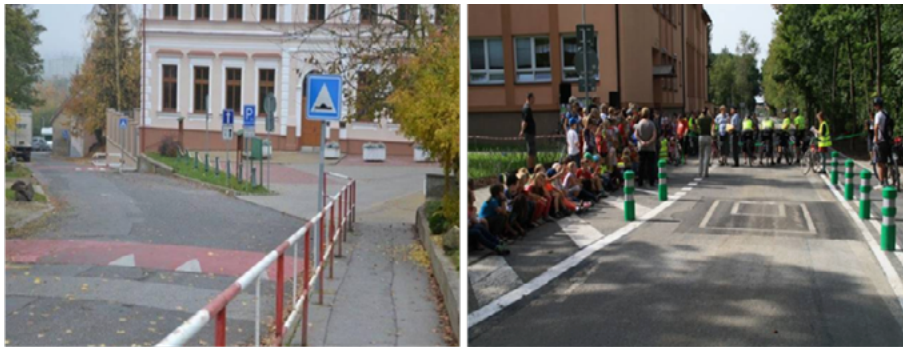
Obr. 25. Krátky priečny prah a dopravný vankúš na upokojenie dopravy pred vstupmi do škôl
