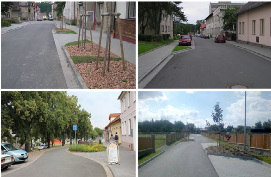
Obr. 46. Vysunuté plochy zelene a chodníkov s cieľom zúžiť alebo smerovo vychýliť jazdný pruh a zabrániť priamemu priehľadu ulicou
