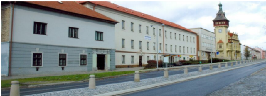
Obr. 44. Stredný deliace pás zo žulových kociek umožňujúci obchádzanie vozidiel v prípade poruchy (mesto Napajedla, ČR)
