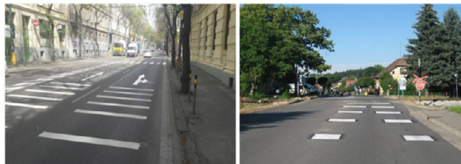
Obr. 29. Optické a akustické brzdy pred priechodom a železničným priecestím logickými brzdami (značka V16), súčasne s radarom spriahnutým s výstražnou svetelnou signalizáciou.
