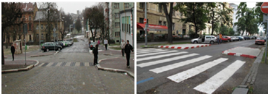
Obr. 47. Vysunuté plochy chodníkov skracujúce dĺžku na prechádzanie a uľahčujúce prechod cez cestu
