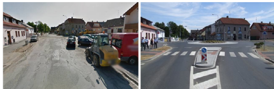
Obr. 39. Prestavba križovatky na prieťahu cesty III. triedy v meste Domažlice, ČR, na malú okružnú križovatku (pred a po)
