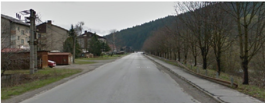
Obr. 15. Chodník na prieťahu cesty II/520 v obci Nová Bystrica, SR, bez funkčných dopravno-inžinierskych opatrení, ktoré by zvýšili bezpečnosť a atraktivitu nemotorovej dopravy
