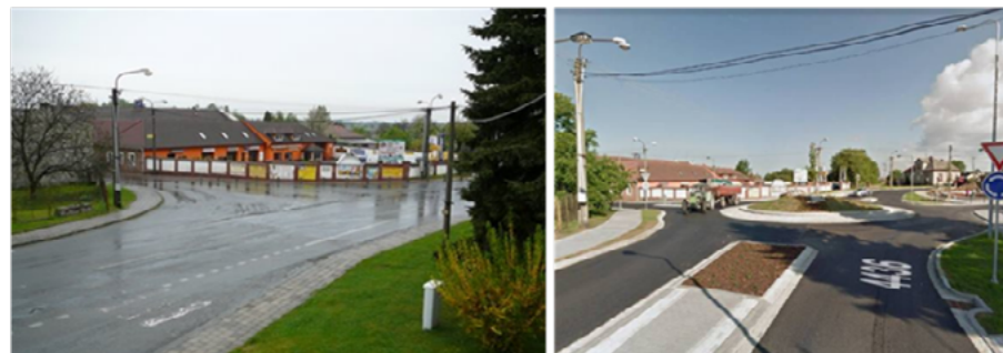
Obr. 42. Malá okružná križovatka na prietahu cesty III. triedy v obci Tověř, ČR, (pred a po)
