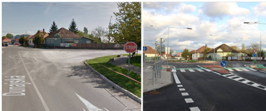
Obr. 40. Prestavba križovatky ciest druhej triedy (II/506 a II/507) v Gabčíkove na okružnú križovatku (pred a po)
