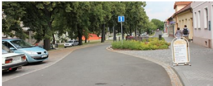
Obr. 34. Smerové vychýlenie komunikácie inštaláciou vysunutej plochy zelene na upokojenie prejazdneho úseku obcou / mestom
