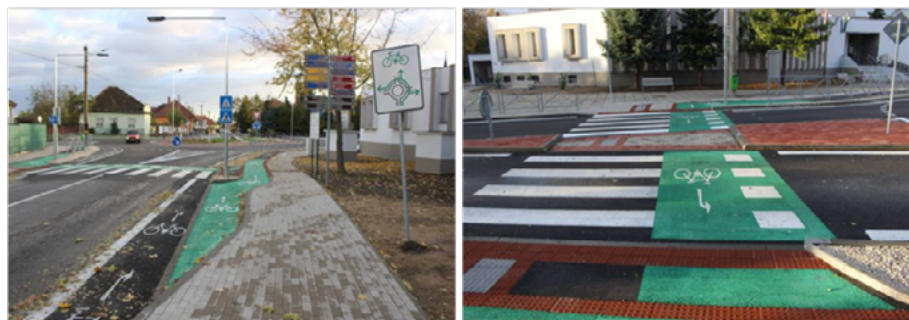
Obr. 41. Príklady bezpečného vedenia cyklistov a chodcov na okružnej križovatke v Gabčíkove
