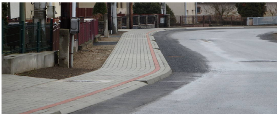
Obr. 16. Novovybudovaný chodník bez „preferencie“ vozidiel vchádzajúcich do príľahlých dvorov nezmyselným znížením úrovne chodník
