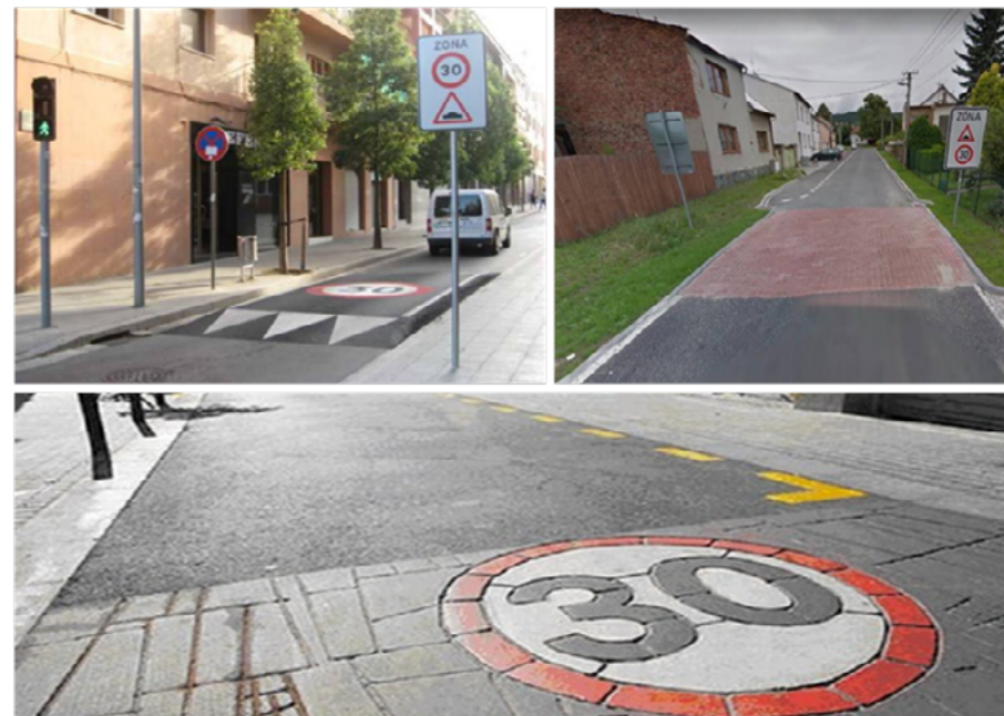
Obr. 55. Označenie a vyznačenie vstupu do Zóny 30 – ZDZ, krátky / dlhý priečny prah, červená dlažba, piktogram max. povolenej rýchlosti na vozovke
