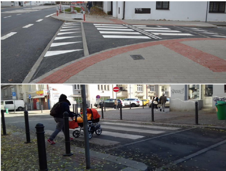
Obr. 49. Dlhé priečne prahy s umiestnením priechodu pre chodcov na vstupoch do nadväzných miestnych komunikácií
