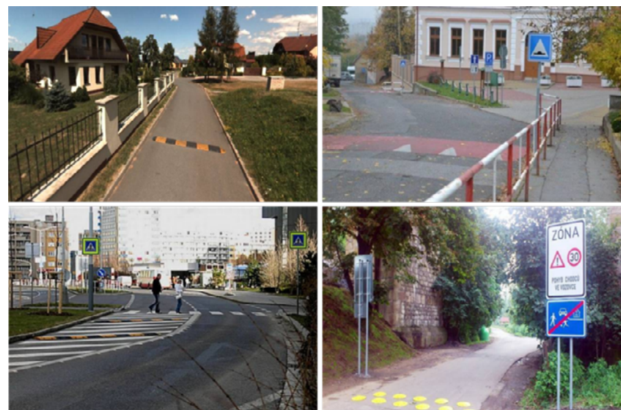
Obr. 52. Krátke priečne prahy rôznych foriem a materiálov a ich umiestnenie pred školami, na vstupoch do obytných zón / zón 30 alebo na zatienených plochách križovatiek pred priechodmi pre chodcov
