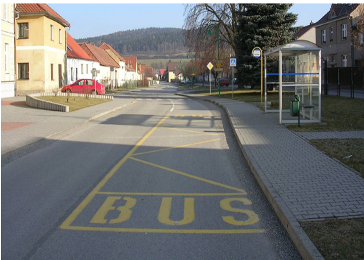
Obr. 10. Zastávka autobusu v jazdnom pruhu vozovky bez stredového ostrovčka
