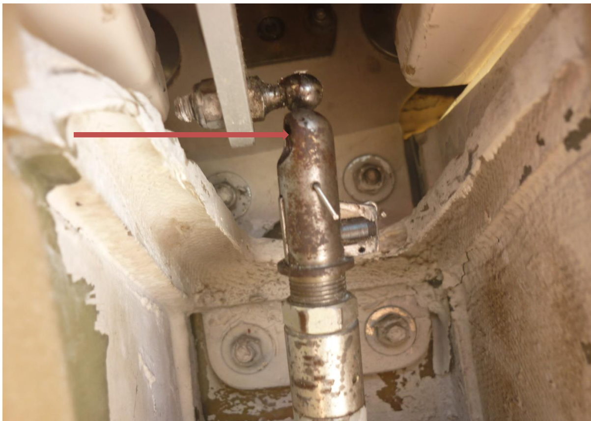
Obr. 7 Nezapojené tiahlo výškového kormidla
