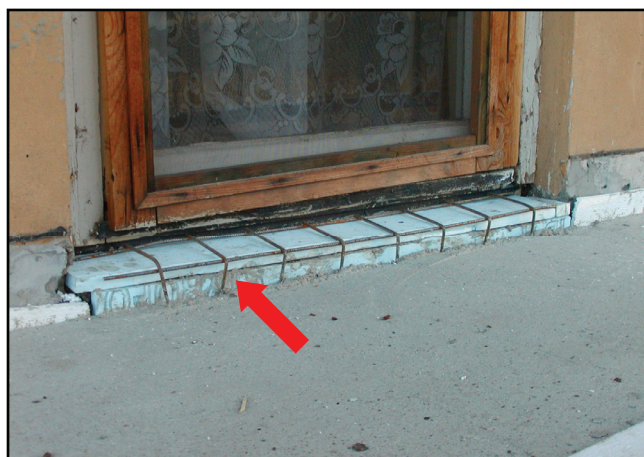
Detailný pohľad na zateplenie styku balkónovej dosky a prahu dverí s viditeľným výstužným rebríkom Detailed view of the insulation of the joint of the balcony board and door threshold with visible reinforcement ladder
