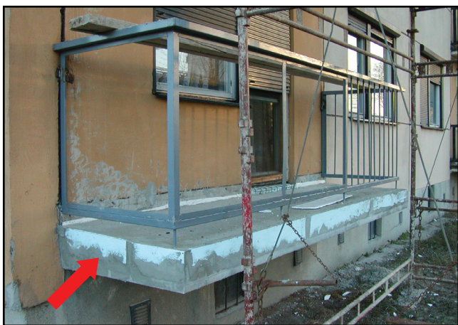
Celkový pohľad na balkón na prízemí v priebehu realizácie po jeho zateplení a osadení konštrukcie zábradlia Overall view of balcony at the ground-floor during the implementation following the insulation and mounting of railing structure
