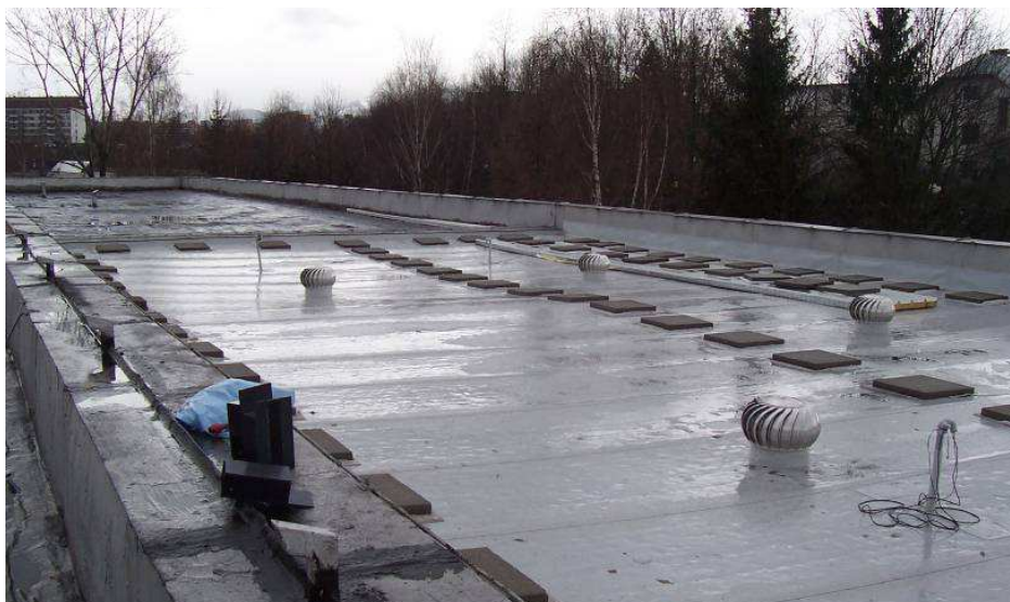
Obr. 4 Dokončená časť strechy – SZŠ Žilina
