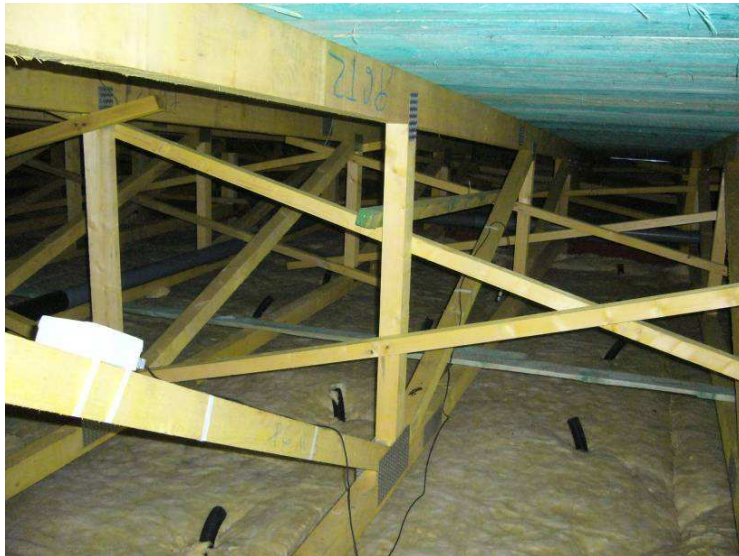
Obr. 8 Pohľad do podstrešného priestoru po rekonštrukcii
