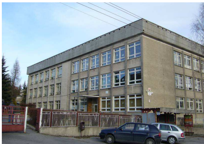
Obr. 6 Pohľad na rekonštruovanú strechu budovy ZŠ
