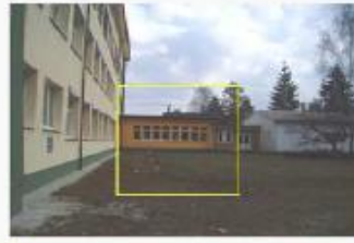
Spojovacia chodba – severná fasáda školy
