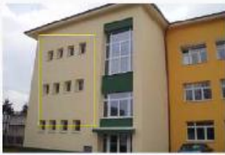
Východná fasáda školy
