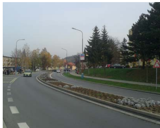
Bardejov, Komenského ulica. Územný plán navrhol humanizovať ulicu aj obostavaním malopodlažnou zástavbou, zrealizoval sa len deliaci zelený pás, pohľad z juhozápadu.
