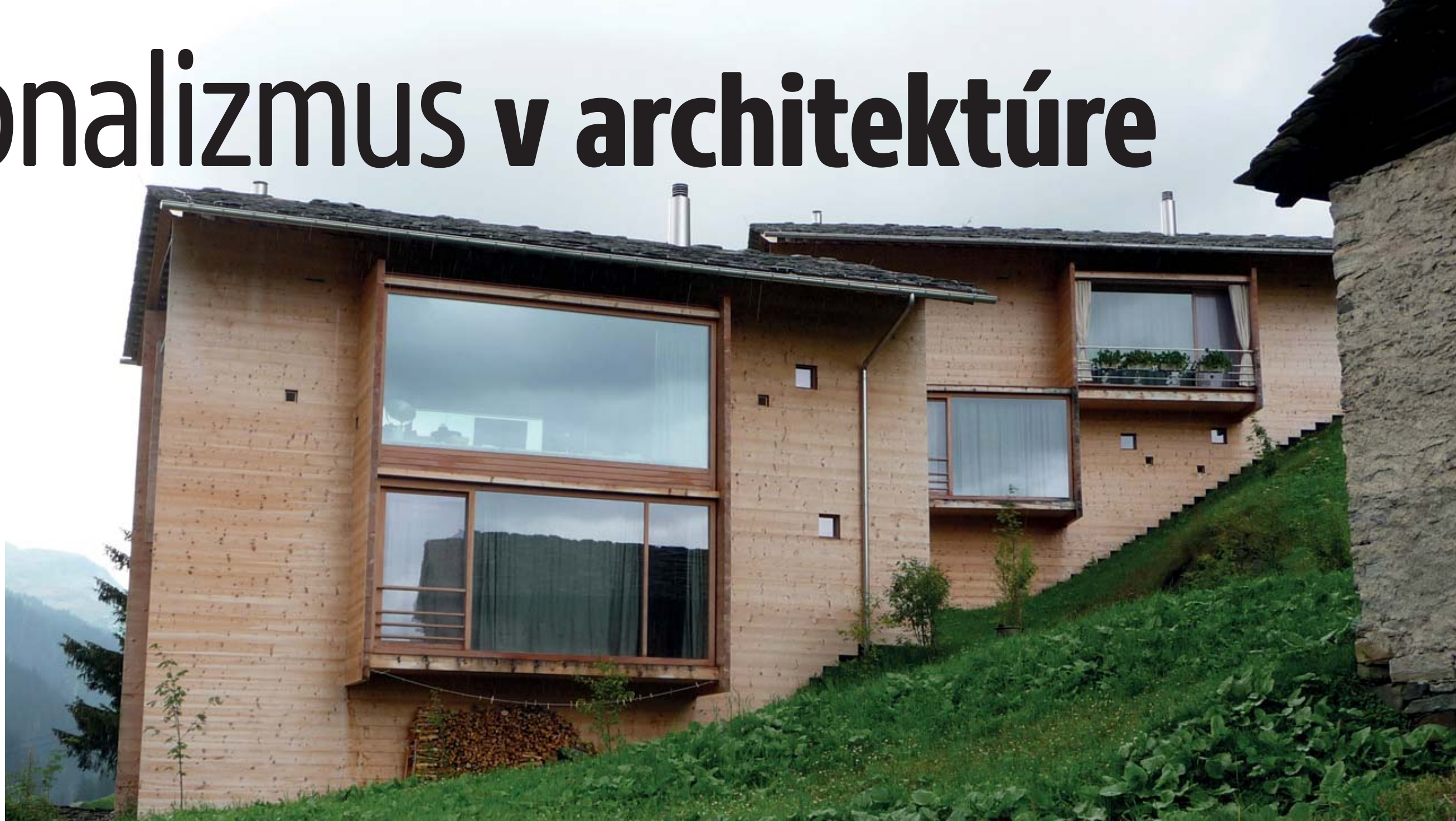
Chaty v Leis, architekt: Zumthor, P.
