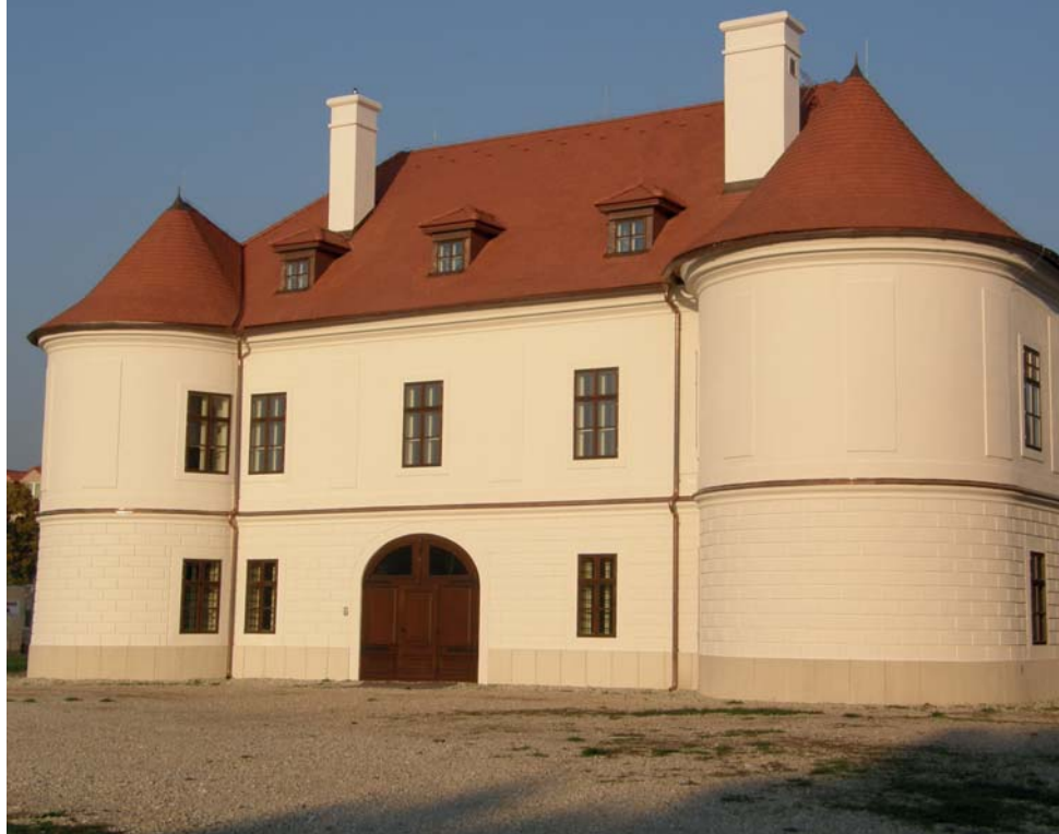
Kaštieľ rodiny Ghyczy v Nových Sadoch po rekonštrukcii je vo vlastníctve obce.
