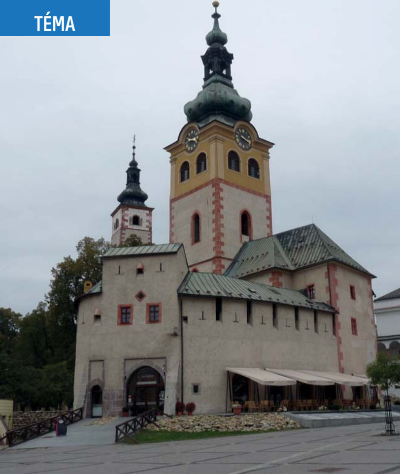
Banská Bystrica, Hrad
