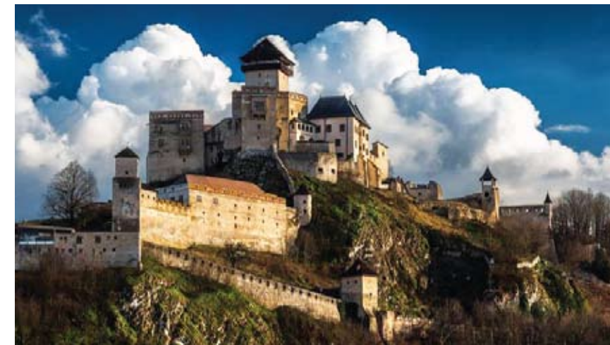
Pohľad na Trenčiansky hrad po rekonštrukcii objektu kasární. Foto: P. Badaj
