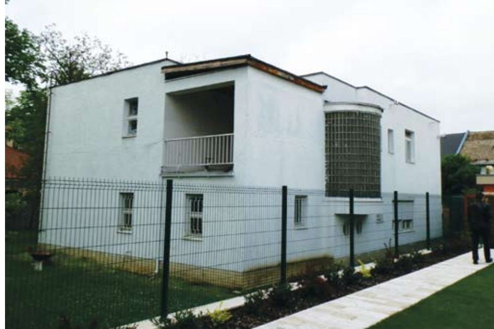
Dnešný stav Winklerovho domu so zamurovanou zadnou terasou. Foto: K. Kubičková
