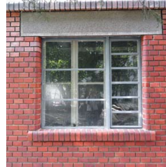
Očistený a doplnený keramický obklad sokla a repasované oceľové okná suterénu. Foto: Z. Holíčková
