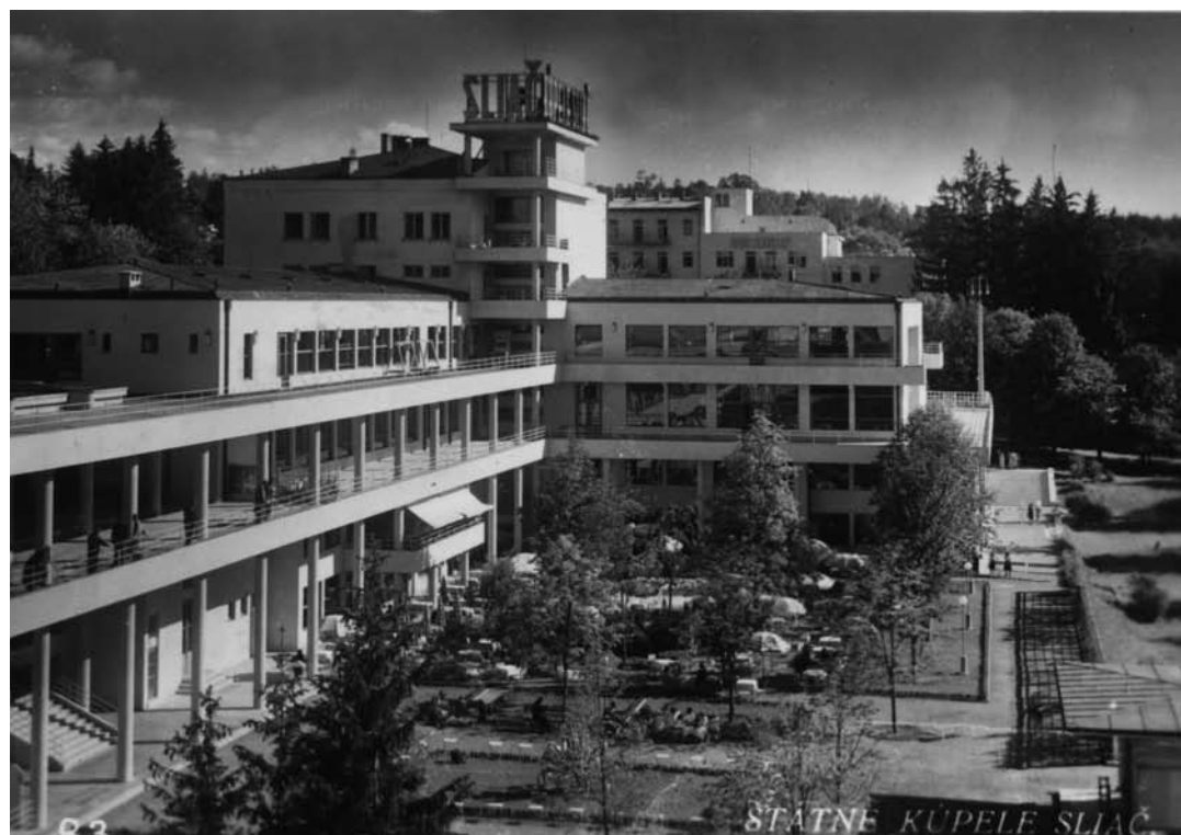
Liečebný dom Palace, Sliač, autor R. Stockar, 1931, 1937. Zdroj: archív Oddelenia architektúry ÚSTARCH SAV
