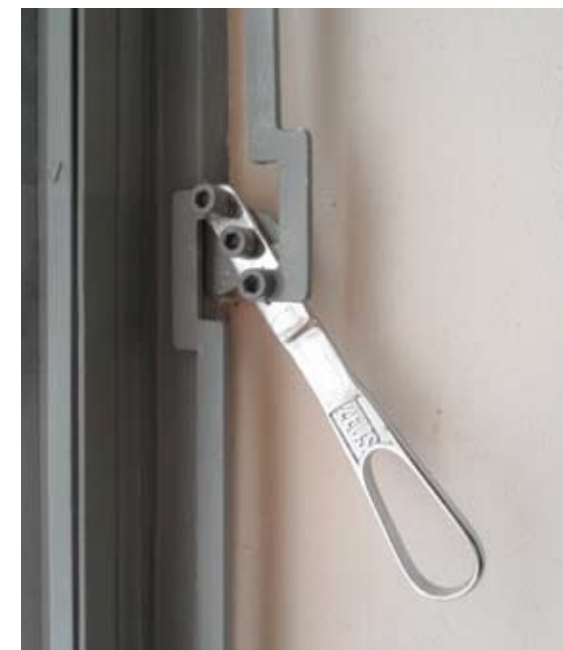
Oceľové okno po reštaurovaní, očistené pákové kovanie značky Zeus. Foto: Z. Holíčková
