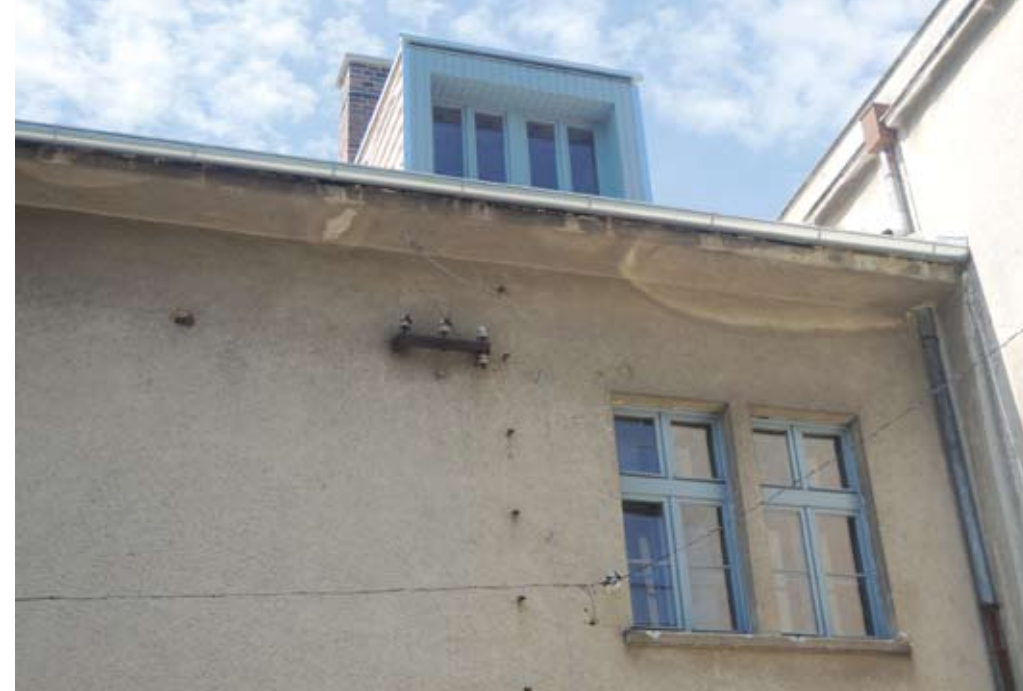
Kontextuálny novotvar vikiera so združeným oknom. Čelo vikiera je riešené zvislo kladeným dreveným obkladom so sivým náterom, bočné steny sú pokryté horizontálne kladeným dreveným obkladom v prirodzenej farebnosti dreva. Foto: Z. Holíčková
