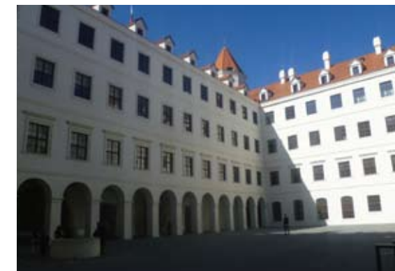
Slohová rekonštrukcia fasády nádvorja Bratislavského hradu po poslednej obnove. Foto: Z. Ondrejková
