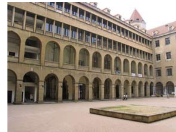
Novotvar fasády nádvorja Bratislavského hradu od akad. arch. D. Martinčeka.
