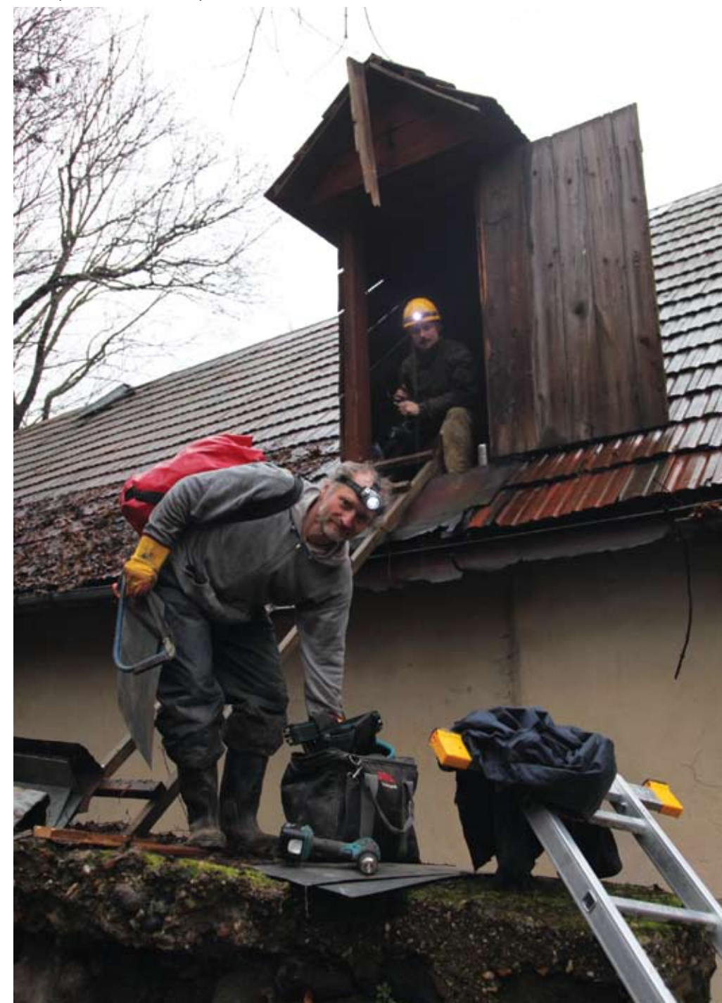
Hronský Beňadik, obhliadka podkrovia. Foto: P. Ižvolt
