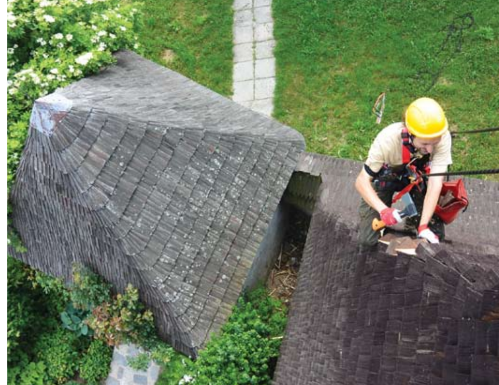
Stará Halič, oprava šindľovej krytiny. Foto: I. Farárik
