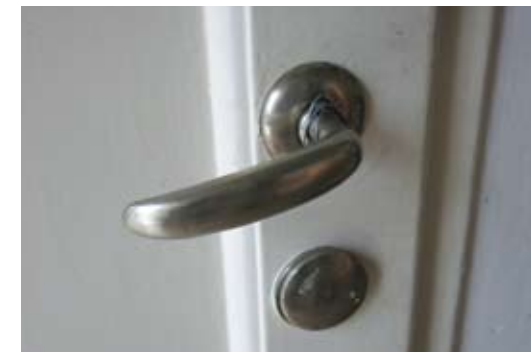
Pôvodná zachovaná kľučka na prízemí domu. Foto: K. Haberlandová
