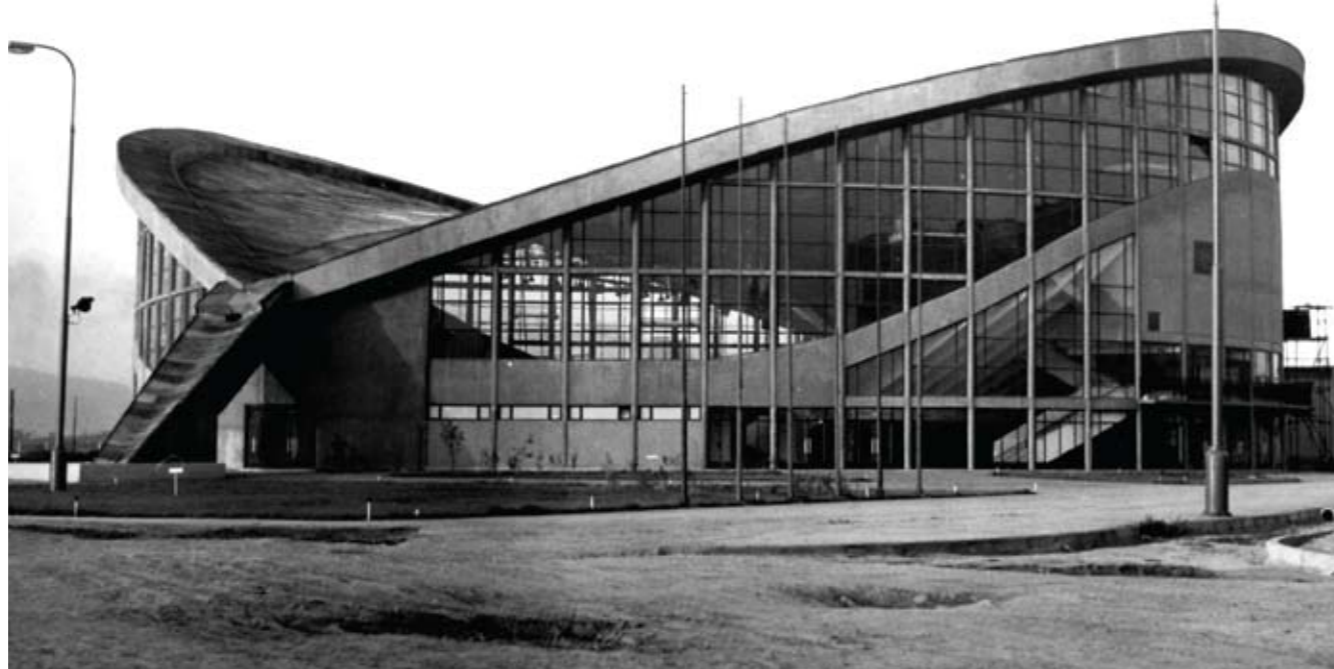
Športová hala Pasienky v Bratislave od architekta Jozefa Chovanca. Spočiatku bolo možné vnímať subtilnosť a eleganciu celej konštrukcie. Zdroj: archív autorky
