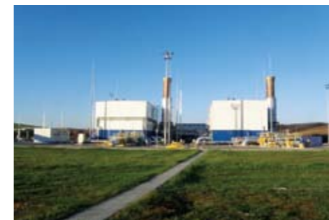
Kompresorová stanica KS 03, Veľké Zlievce
