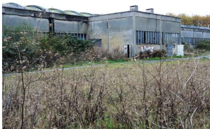
„Tunel“ pred premenou
