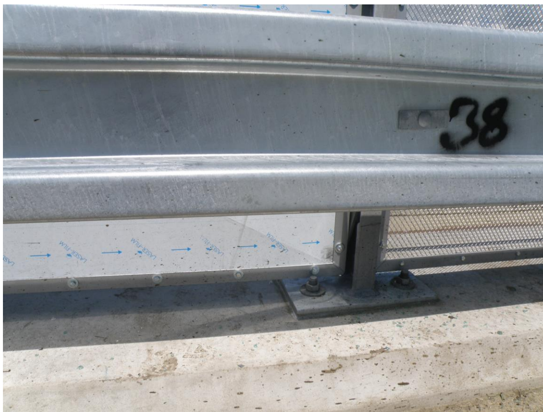
Obrázok 22 – Zábradľové zvodidlo ZMS4/H3 – pohľad na plnú výplň a výplň z ťahokovu
