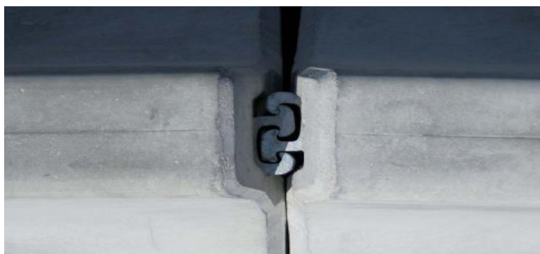
Obrázok 1 – Zámok zvodidla, v [mm]
