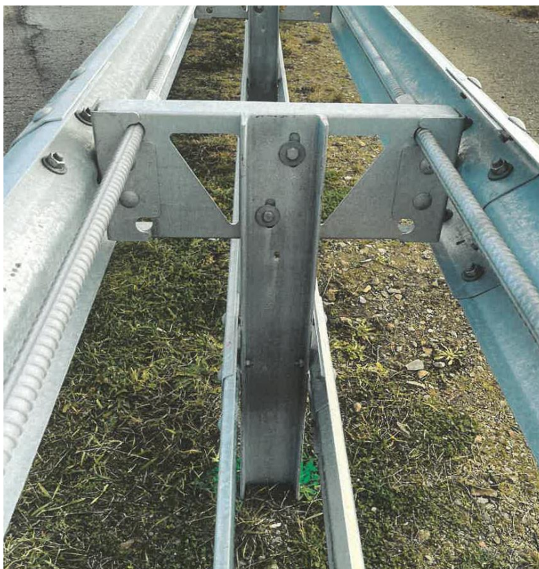
Obrázok 114 – Pohľad na zvodidlo OS3A-2/H3-1
