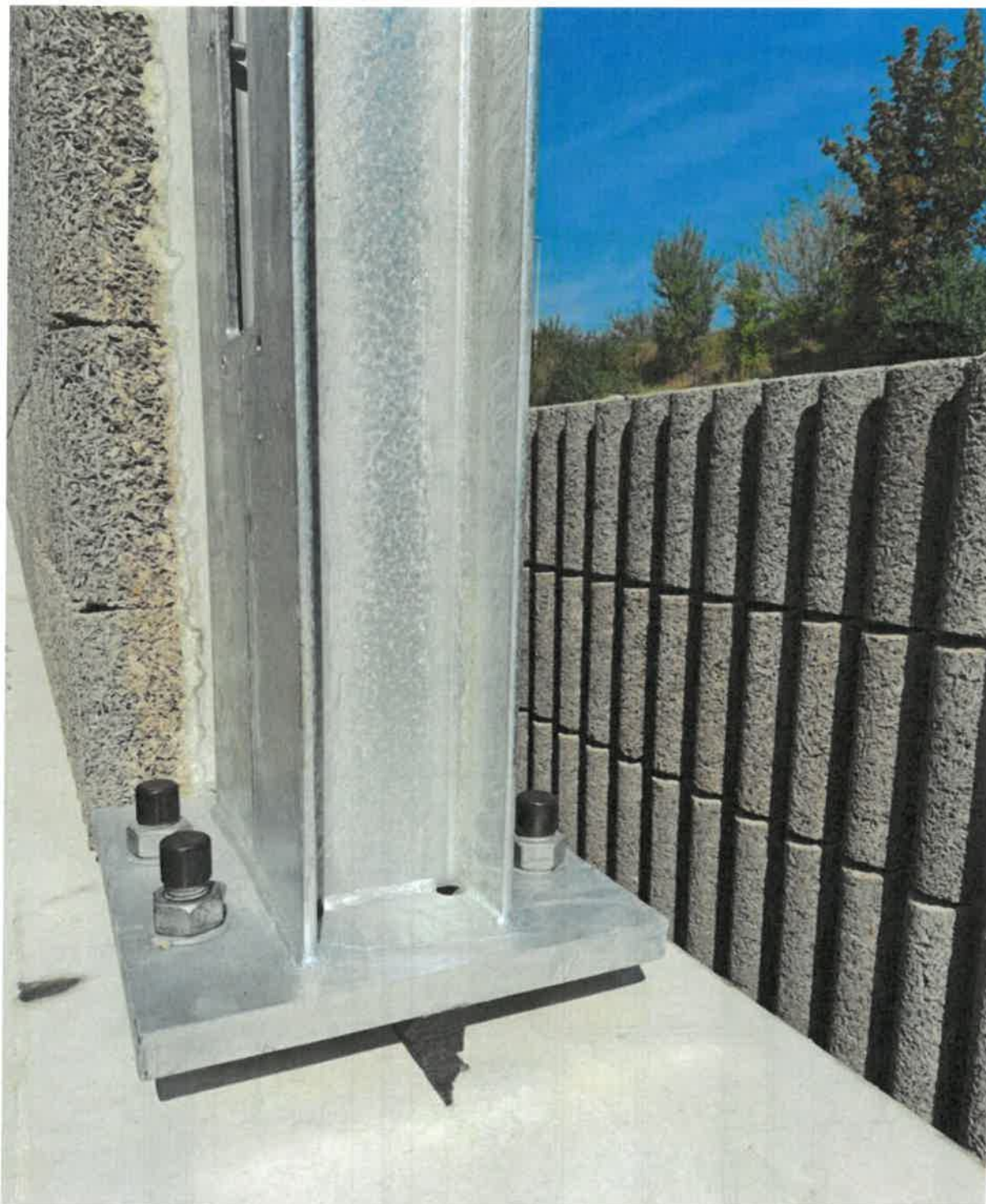
Obrázok 5 - Bežný dielec DB 100 NBF T180 TA, detail kotvenia skrutkami
