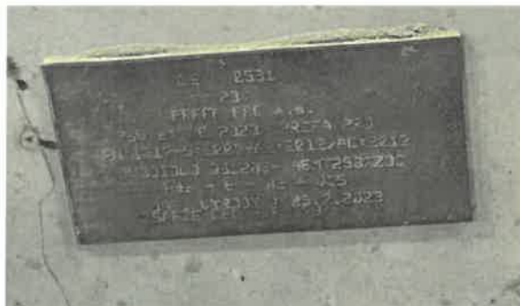
Obrázok 21 Detail kovového alebo plastového štítku na pohľadovej strane dielca
